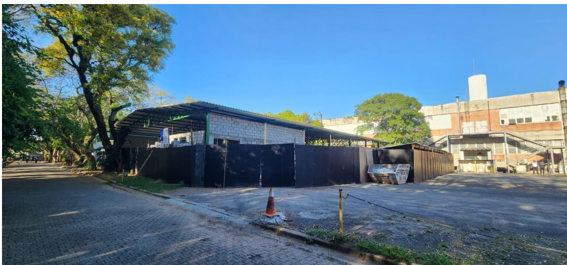
Figura 2 - Obras do novo refeitório estudantil - previsão de entrega em 2026.
