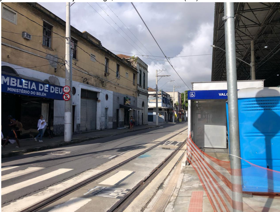
Figura 4 - Obras da Estação Valongo, no Centro de Santos (SP).
