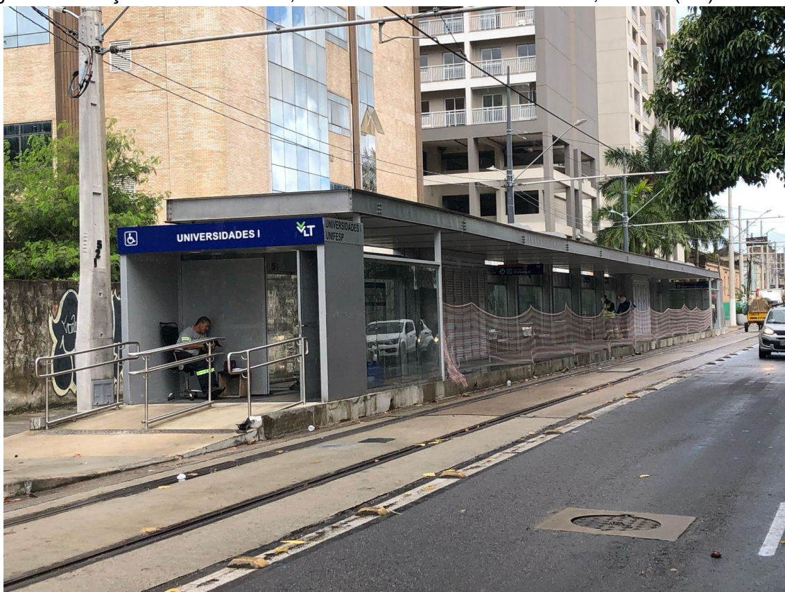
Figura 2 - Estação Universidades I, localizada no bairro Vila Mathias, Santos (SP).
